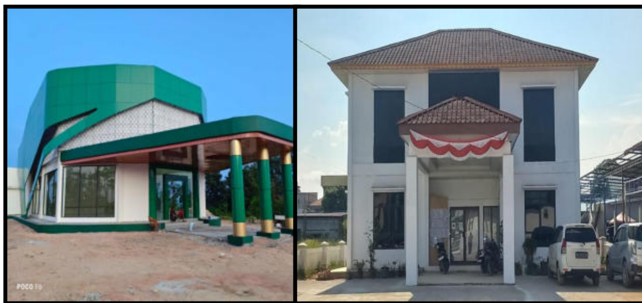
Gambar II.2. Sarana dan Prasarna Infrastruktur yang Terbangun
